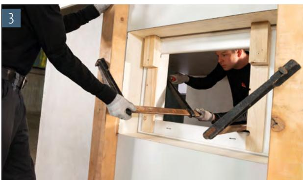
Therm® Block ankleben und mit Kanthölzern und Zwingen für ca. 1 Stunde fixieren. Während des Trocknungsprozesses kann schon mit Punkt 4 dieser Anleitung fortgefahren werden.
