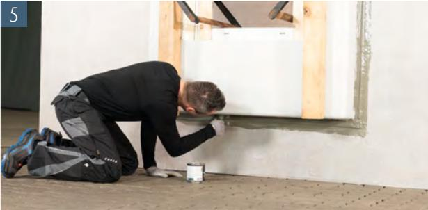
Therm® Block umlaufend in 2 Arbeitsgängen mit Aqua Blocker aus Dose oder Eimer abdichten. Das Abdichtungsmaterial in einer Breite von ca. 70–80 mm auftragen. Der Abdichtungsflansch des Therm® Blocks muss vollständig bedeckt sein. Je Arbeitsgang sollten ca. 1 ½ kg Aqua Blocker zum Einsatz kommen. Die Trocknungszeit zwischen den beiden Arbeitsgängen sollte ca. 3-4 Stunden betragen. Nach 24 Stunden kann die Perimeterdämmung angearbeitet werden.
