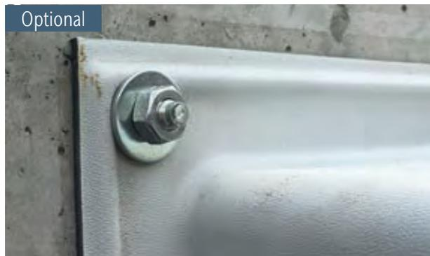
Optional können die Bohrungen im Abdichtungsflansch zum Aufhängen des Therm® Blocks genutzt werden. Hierfür den Therm® Block an die Wand halten und die Bohrpunkte anzeichnen. Nach dem Bohren (10 mm) das Bohrloch reinigen und die beiden Schwerlastanker einschlagen. Sollte der Therm® Block um 180° gedreht worden sein, sind die Bohrungen im Flansch bauseits zu bohren
