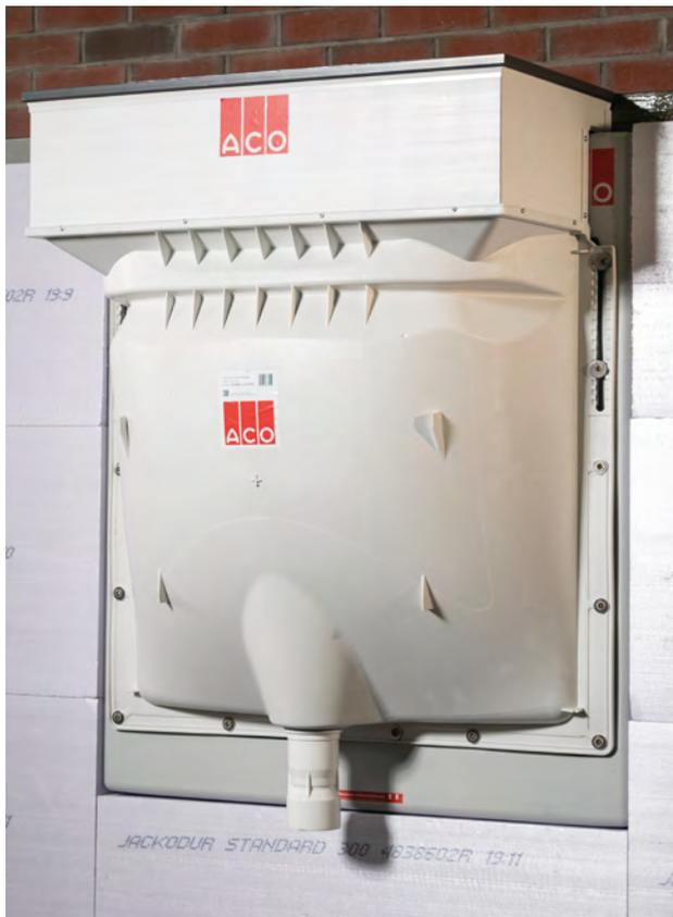
Nach Durchtrocknung des Aqua Blockers kann die Perimeterdämmung angearbeitet werden. Die Übergänge von Dämmung zu Therm® Block können mit Dämmplattenkleber ausgespritzt und mit einem lösungsmittelfreien Abdichtungsmaterial überarbeitet werden
