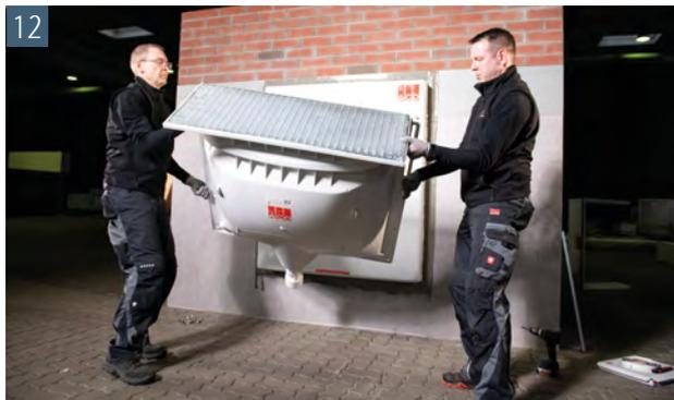
Hängen Sie den Lichtschacht an die zuvor gesetzten Schrauben an und überprüfen Sie die korrekte Lage des Lichtschachtes. Im Anschluss kann die Schutzfolie vom Abdichtungsband entfernt und der Lichtschacht leicht angedrückt werden
