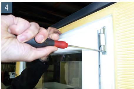
4. Fenster gut festhalten und Axerstift nach unten ziehen. Bei Bedarf Schraubendreher zu Hilfe nehmen
