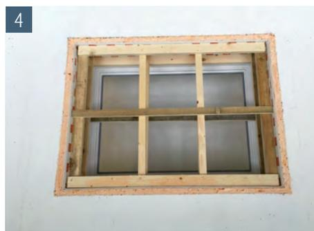
4 Aussteifungsrahmen einfügen und Leibungselement rundum einschäumen
