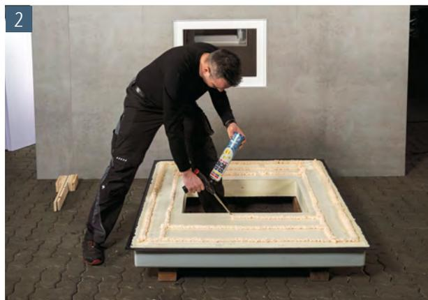
Ausreichend Dämmplattenkleber wie dargestellt aufsprühen. Therm® Block mit Fensterausparung: ca. ½ Dose
