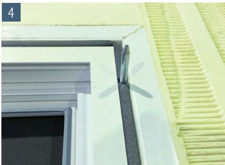
4 Stecken Sie die beiden Stahlbolzen jeweils links und rechts in die Zarge ein. Bringen Sie, wie vorher beschrieben, den Dämmplattenkleber auf
