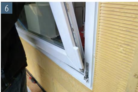
6 Flügel anschließend vom unteren Ecklager heben
