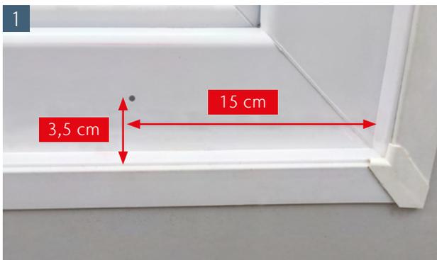
Von außen jeweils links und rechts unten zwei 8 mm Bohrungen einbringen. Bitte durchbohren Sie nur die äußere Wandung
