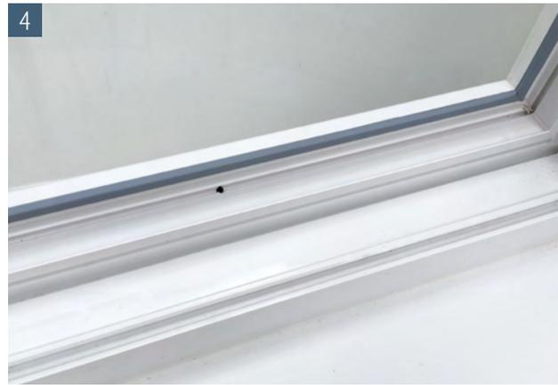
Entfernen Sie abschließend die Bohrspäne
