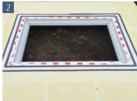
2 Kompriband etwas aufquellen lassen
