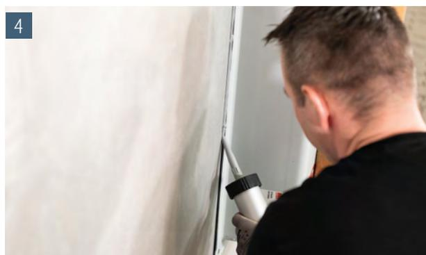
Therm® Block umlaufend mit Aqua Blocker aus der Kartusche abdichten. Bitte ca. 30 bis 60 Minuten antrocknen lassen
