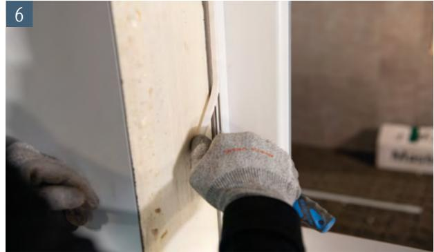
Sofern sich ein ACO Kellerfenster in der Wand befindet kann die Dichtungsschnur entfernt werden
